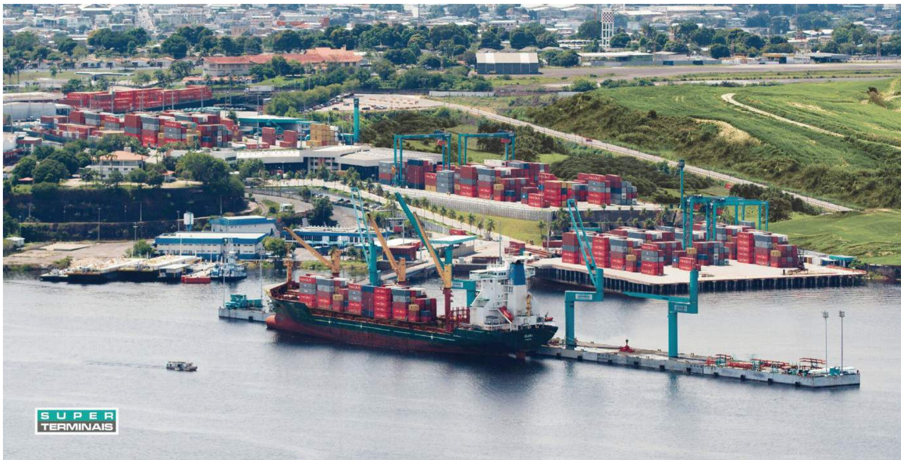
Figura 1.3 - Vista da área de manobra de chegada e de saída do cais.
